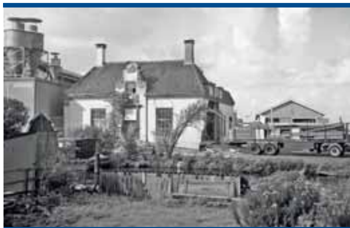
Demontage van Villa Rote op z'n oude locatie aan de Overtoom.
