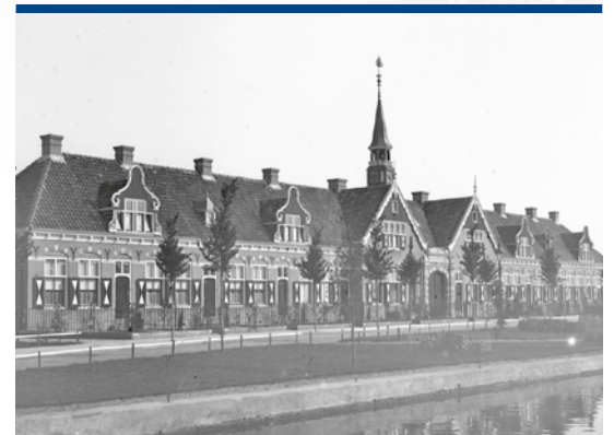
Hof van Saenden in Wormerveer. Tien arbeiderswoningen gebouwd in 1915/1916.
