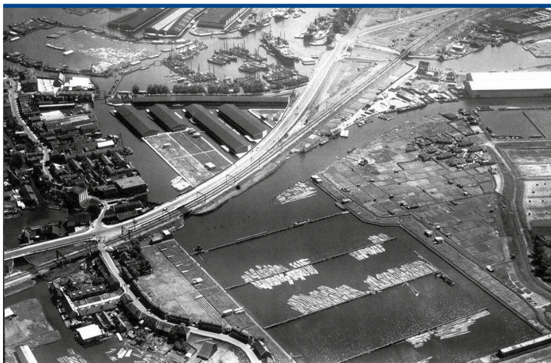
De balkenhaven van Bruijnzeel. Boven het houteiland van William Pont in de Voorzaan.
