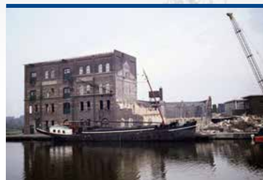
Sloop van de fabriek van Molenaar's Kindermeel aan de Vaardijk.
