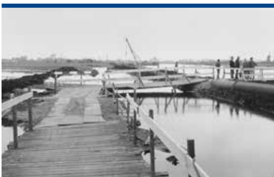
Aanleg van de A8 bij de Middel.
