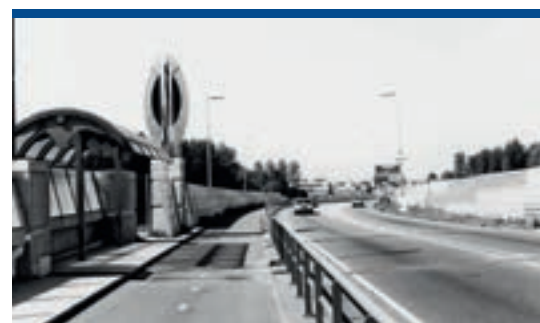
De Den Uijlbrug over de Voorzaan was een schakel in de verbinding van Zaandam met Beverwijk.
